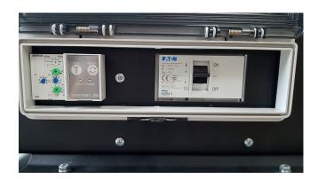
Der Generator ist über einen Leistungsschutzschalter gesondert abgesichert (ab TG30/15).
